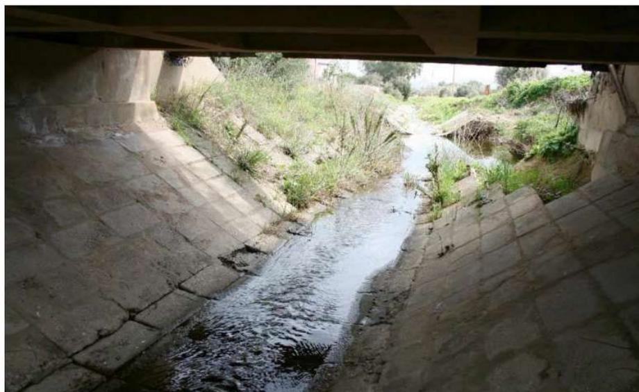
Figura 4: Sistemazione dell'alveo sotto il ponte A
